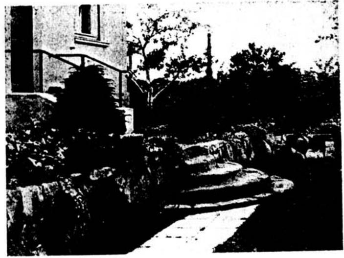
Abb. 26. Der Bau einwandfreier Findlingsmauern setzt große Übung und Fertigkeit voraus.
