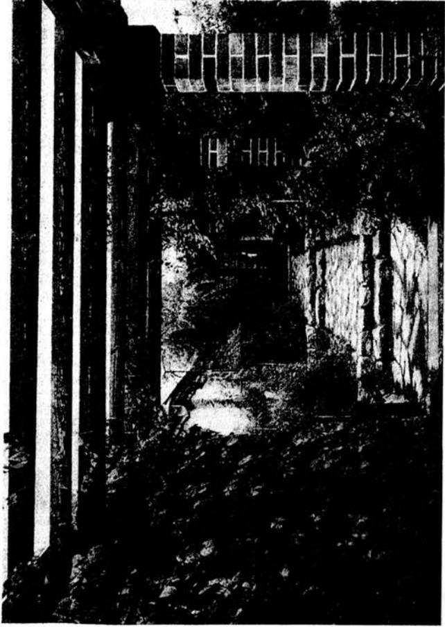
Abb. 42. Das Lattendach der Pergola ruht in gehörig weiten Abständen auf einer von Ziegelsteinen
