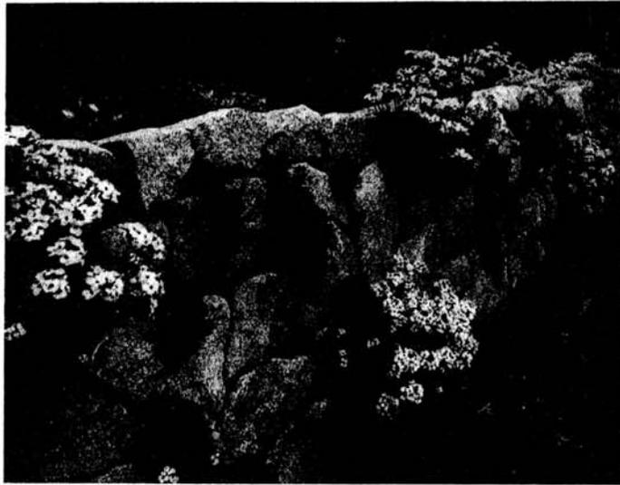
Abb. 19: Die Stützmauer aus gespaltenen Findlingen wird als Trockenmauer gebaut, damit in ihren Fugen Polsterstauden blühen können.
