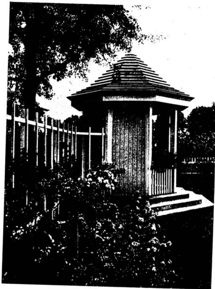
Abb. 38. Gartenhaus mit Wänden und Dach aus Brettern (vgl. Abb. 37).
